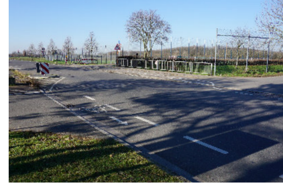
Verkehrssituation an der Stommelner Straße in Höhe des Randkanals
